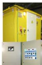
В качестве контроллера управления устанавливаются надежные и простые в управлении контроллеры КСИ-5130 и ScadaPack. Установка оснащена автоматическими системами обогрева, освещения, вентиляции, а так же системой оповещения при пожаре и загазованности. Блок электроники выполнен в шкафу, легко монтируется в штатном помещении автоматики.
