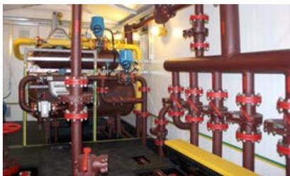
В качестве запорной арматуры используются дисковые задвижки ЗД производства ООО «Завод НГО «ТЕХНОВЕК» с условным проходом Ду50, Ду80 и Ду100, за счет чего увеличена рабочая зона для обслуживающего персонала.
